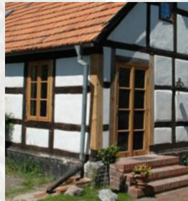
Nachbau der Fenster und Türen nach Originalvorlage in einem Fachwerkhaus
