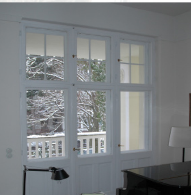
Neuanfertigung von Kastendoppelfenstern im Altbau
