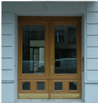
Nachbau einer historischen Hauseingangstür
